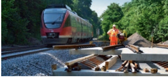
Gleiserneuerung Kölner Dieselnetz
